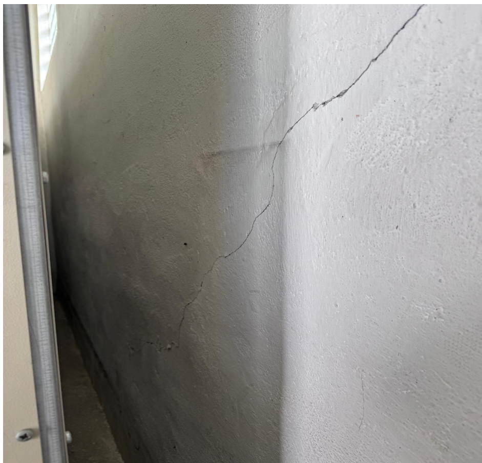
Fot.9 Pomieszczenie rozdzielnic 400V (nr 2) – rysa w ścianie w osi A-A
