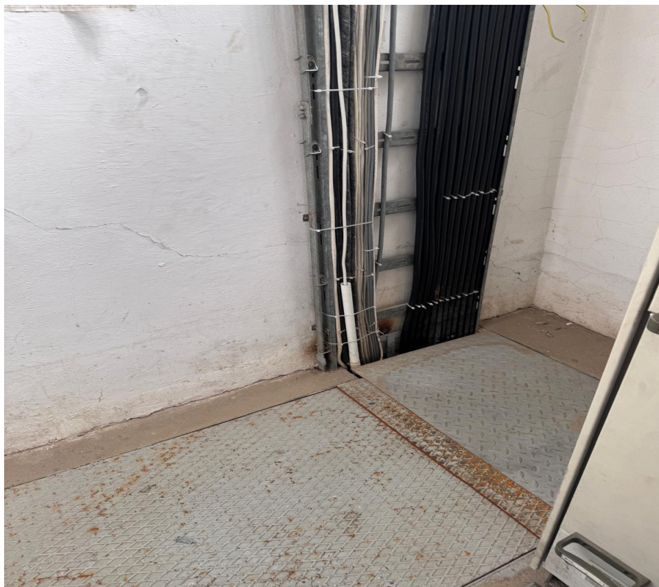
Fot.9 Pomieszczenie rozdzielnic 400V (nr 2) – rysa w ścianie w osi 3-3
